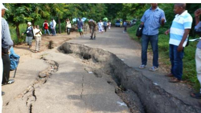
*Fissures et affaissement de la chaussée*
